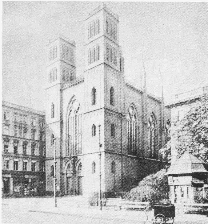
Die Friedrich-Werdersche Kirche (1824–1830), Ansicht von Südosten
