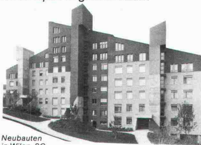
Neubauten in Wilen, SG. Überbauung mit Holz/IV-Fenstern.
