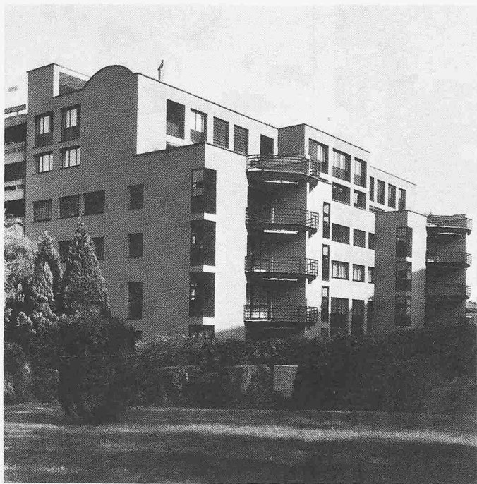
Ansicht des «Anbaus» von Westen
