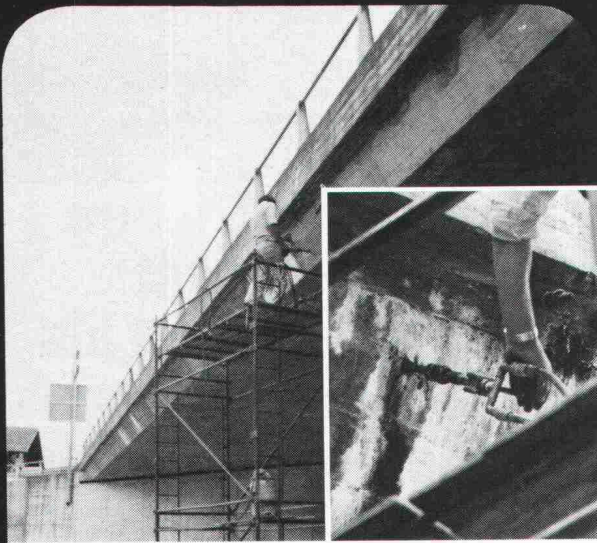
Risse in Betonbauwerken Abdichtung mit Renesco- Flexin-Injektionen
