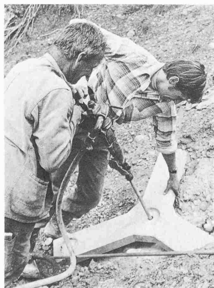
Bild 8. Schlupf. Steinfil - Sternelemente werden zu mehreren übereinander im Nagelfluh verankert. Kombinierte Bauweise. (Photo: A. Blatter)
