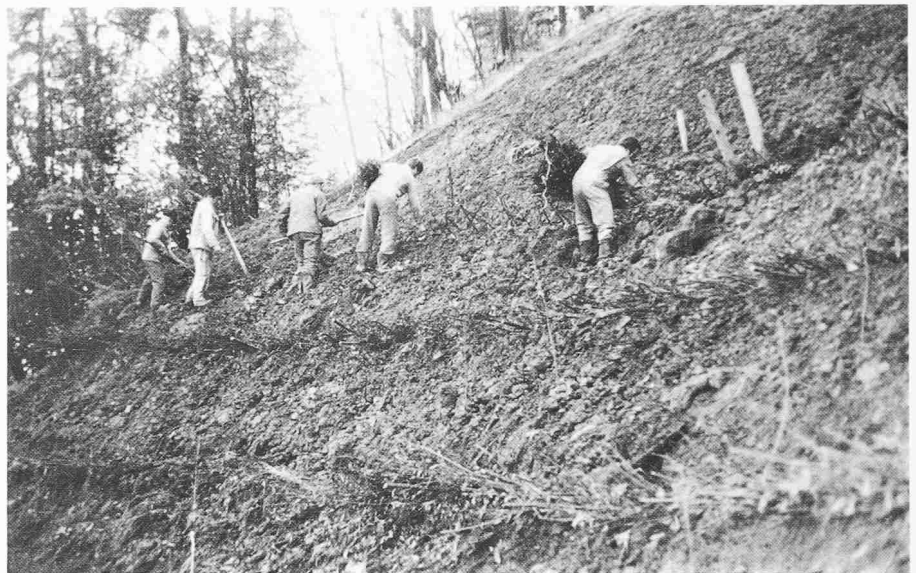
Bild 9. Schlupf. Der Schlupf wird von unten nach oben mit Buschlagen verbaut. (kombinierte Bauweise)
