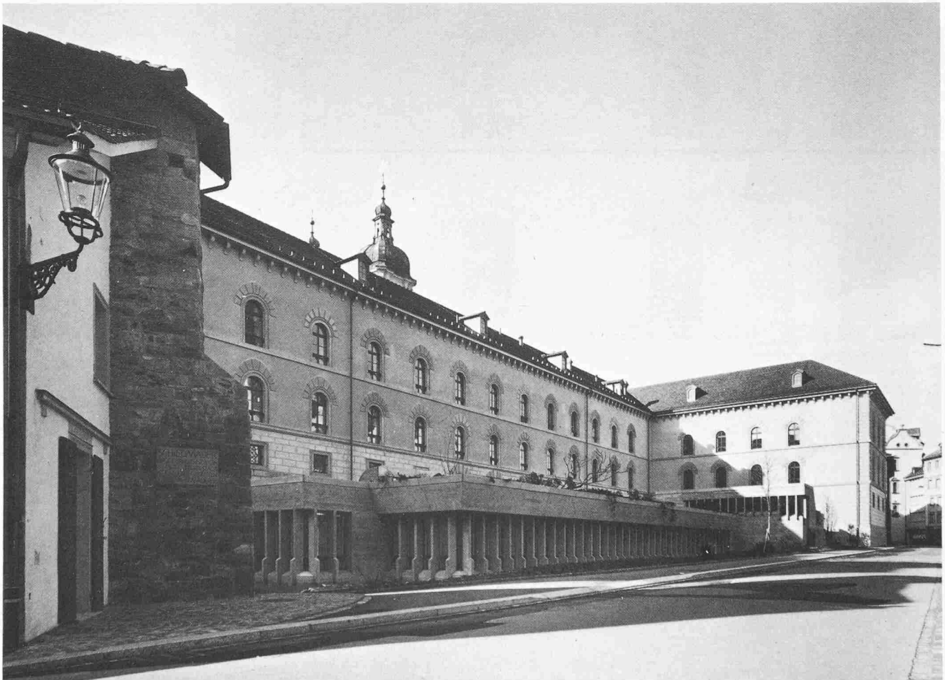
Blick von der Zeughausgasse auf die Rückseite des Nordflügels des Regierungsgebäudes. Links: die renovierte und etwas verlängerte geschichtsträchtige Schiedmauer. Mitte: das niedere, neuzeitlich gestaltete Sockelgeschoss mit Büros und Lesesaal sowie grossem Gerichtssaal beeinträchtigt die äussere Erscheinung des restaurierten Nordflügels nicht
