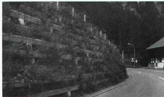
Staatsstrasse Zweilütschinen BE
