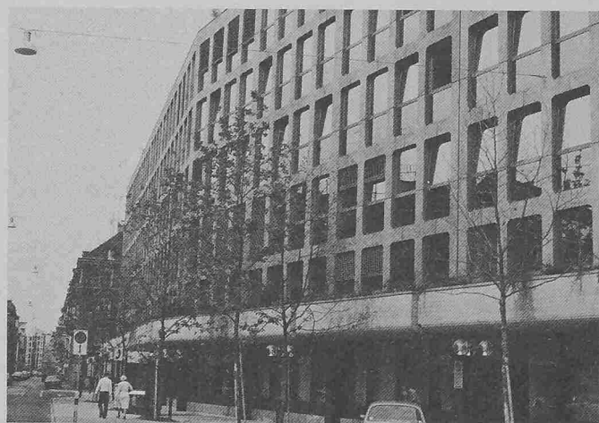
Verwaltungsgebäude der Kreistelefondirektion Zürich. Fassade aus Aluminium-Herdgussplatten
