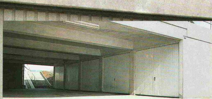
Aus 2 Reihen Unterflur-Garagen und vorgefertigten Rippenplatten über dem Mittelteil, kann eine wirtschaftliche Einstellhalle konstruiert werden.
