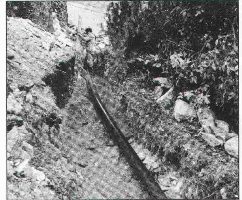
10.45 Die erste Länge ist verlegt...
