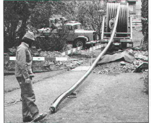
10.04 Die Verlegung der FLEXWELL-Leitung beginnt...
