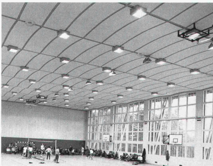
- Turnhalle Magglingen. Turnhallenboden-Sanierung.
