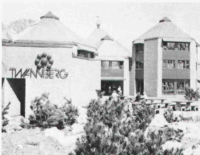
- Feriendorf Twannberg. Bodendämmung in Zimmern und Hallen (360 m3).
