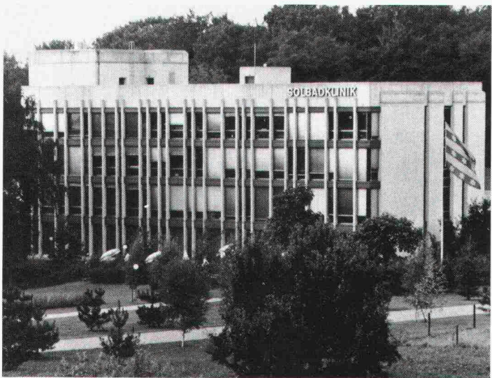
- Solebad Rheinfelden. Bodendämmung auf Erdreich.
