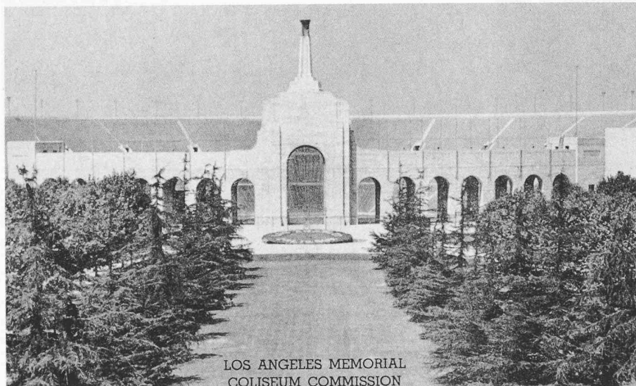
Bild 18. Los Angeles Memorial Coliseum, 1932 und 1984. Tribünenbreite 60 m
