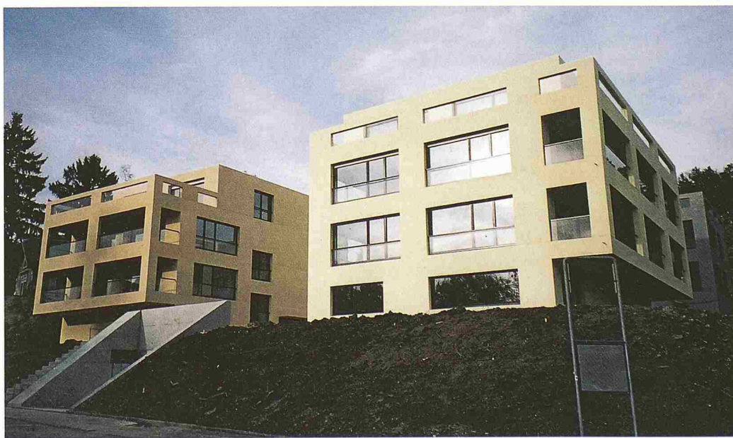
Auf dem Areal der ehemaligen Dépendance des Hotels Zürichberg an der Susenbergstrasse wird dieser Tage das jüngste Werk von Annette Gigon und Mike Guyer fertiggestellt. Die drei farblich aufeinander abgestimmten Bauten enthalten je drei grosszügige Mietwohnungen. Bauträgerin ist die Gastronomiegruppe ZFV (Bild: H. Helfenstein)
