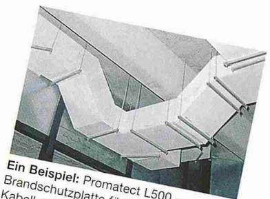
Ein Beispiel: Promat L500 – Brandschutzplatte für Lüftungs- und Kabelkanäle.
