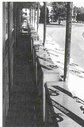
Sto Fassadendämmplatten, mit Gerüstfolie Safety am Gerüsthandauf befestigt
