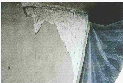
Original-Kalknaturputz des 18. Jahrhunderts unter Putzschicht von 1894
