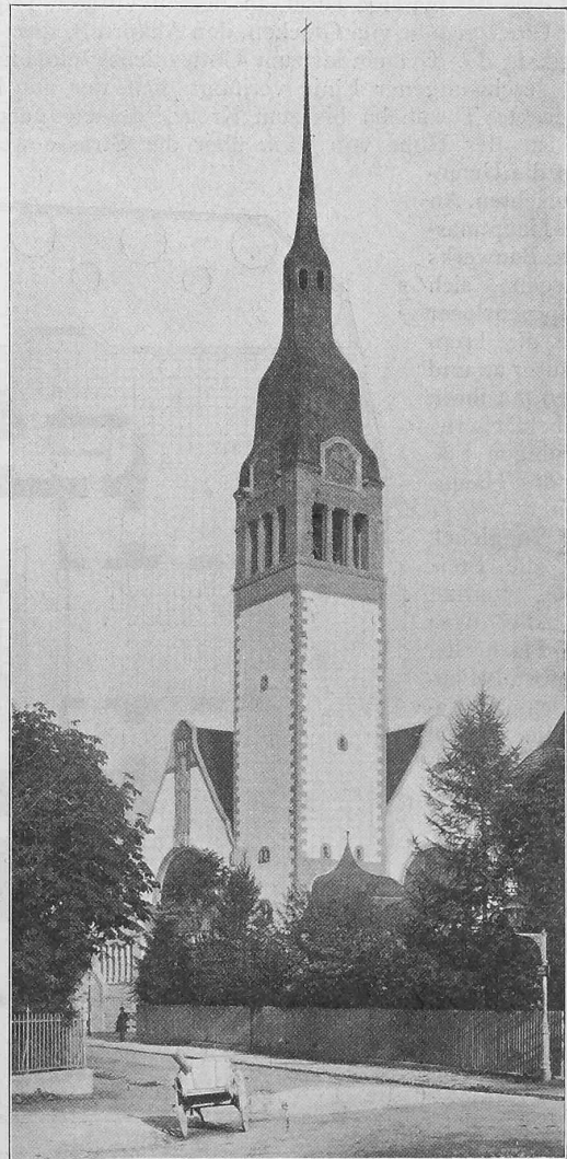
Abb. 2. Ansicht der Pauluskirche von der Freien Strasse aus.
