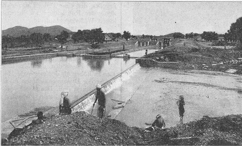
Abb. 3. Ansicht der Einmündung der beiden Zulaufkanäle in das Wasserschloss sowie des Ueberlaufes aus dem letztern.
