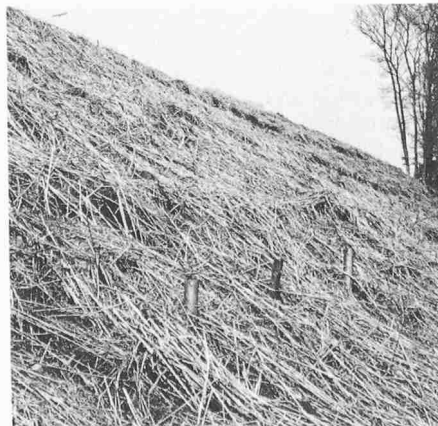
Bild 15. Kerzers N1, Mühle Grau. Die geschüttete Kiesböschung wurde mit Stechkölzern vernagelt, hinter welche Weidenstämme gerollt wurden; die Fläche wurde mit Schilf abgedeckt. (Stabilbauweise)
