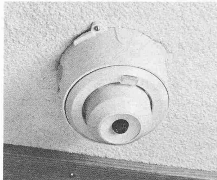
Bild 9. Der gleiche Melder, knapp über dem Boden montiert, um schwere Gase wie Propan usw. anzuzeigen
