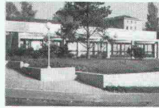
Hôpital de Cery Lausanne
