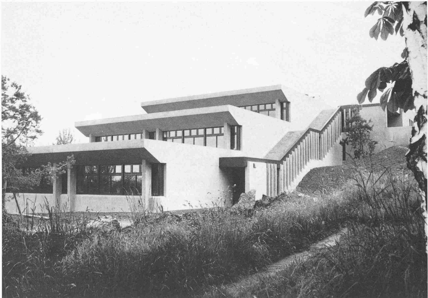
Schulhaus Büel B in Unterengstringen, Ansicht von Nordosten
