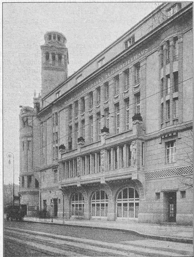
Abb. 6. Fassade des Restaurationsgebäudes an der Motzstrasse.
