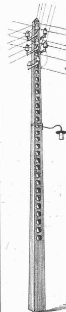
Bewährter, gefälliger und billiger Mast für elektrische Fernleitungen, für Telegraph und Telephonleitungen.
