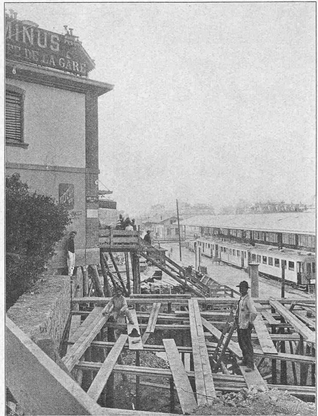
Abb. 7. Unterfangen der Ecke des Hauses Nr. 3.
