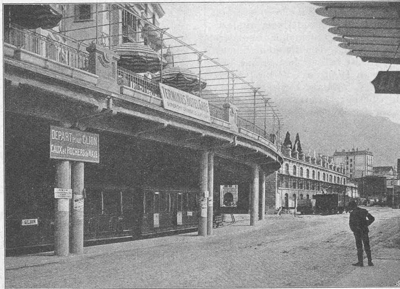
Abb 10. Eisenbetonterrasse im Bahnhof Montreux; Durchblick nach dem Tunnel Nr. 2.
