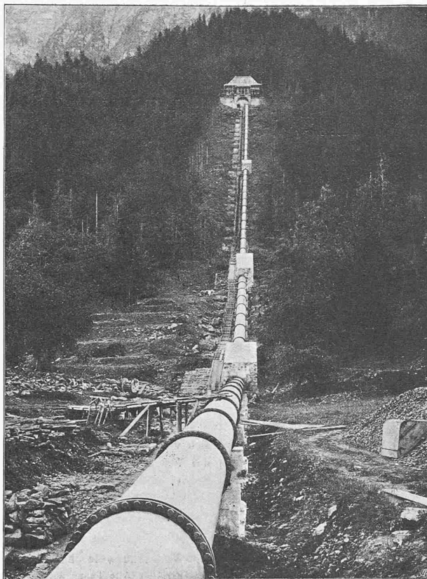
Abb. 17. Wasserschloss und Druckleitung I.
