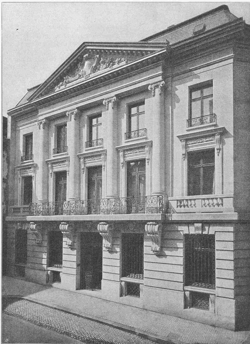
Abb. 5. Fassade an der Freienstrasse.
