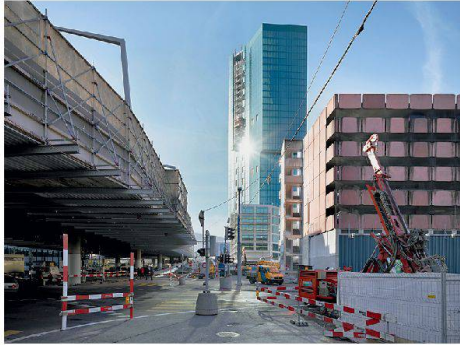
An der Hardstrasse im Zürcher Industriequartier werden die Hardbrücke saniert und der «Prime Tower» gebaut (Foto: Hannes Henz)
