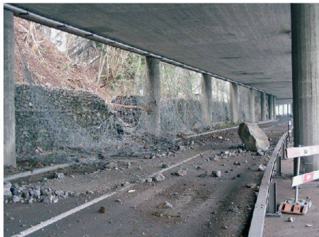
Felssturz im Oktober 2009 (Foto: Astra)
