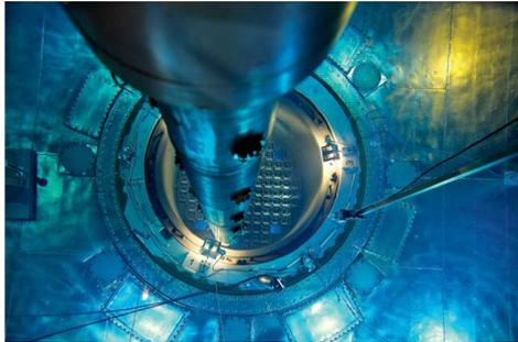
Blick in einen offenen Reaktor des Kernkraftwerks Beznau, wo während einer Revision verbrauchte Brennelemente ausgetauscht werden.
