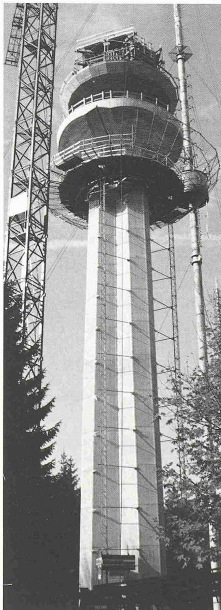
Der 55 m hohe Betonunterteil des zukünftigen, insgesamt 185 hohen Antennenturms auf dem Üetliberg ist fertiggestellt (Bild: Brunners Erben)
