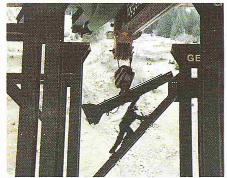
Bild 9. Montage der Querverstrebungen Bildautor: A. von Glutz
