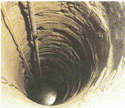
Bild 7. Unverrohrtes Bohrloch, Tiefe ca. 12 m Bildautor: A. von Glutz
