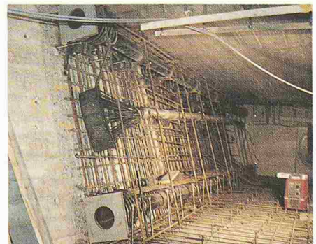
Bild 10. Brückentrog-Verstärkung, Vorspannung und Armierung Bildautor: A. von Glutz
