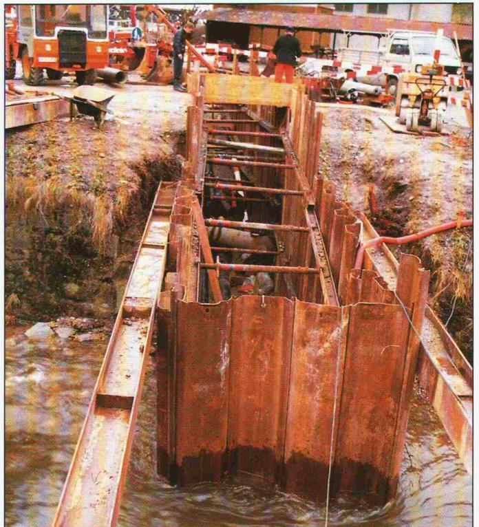
In Etappen wurden die Rohrleitung durch den Wildbach vorgebaut. Die einfache Montage von Steckmuffenrohren mit FZM-Umhüllung erleichterte dabei die Arbeit der Verlegeequipe im Rohrgraben, rund 2 m unter der Flusssohle, erheblich.
