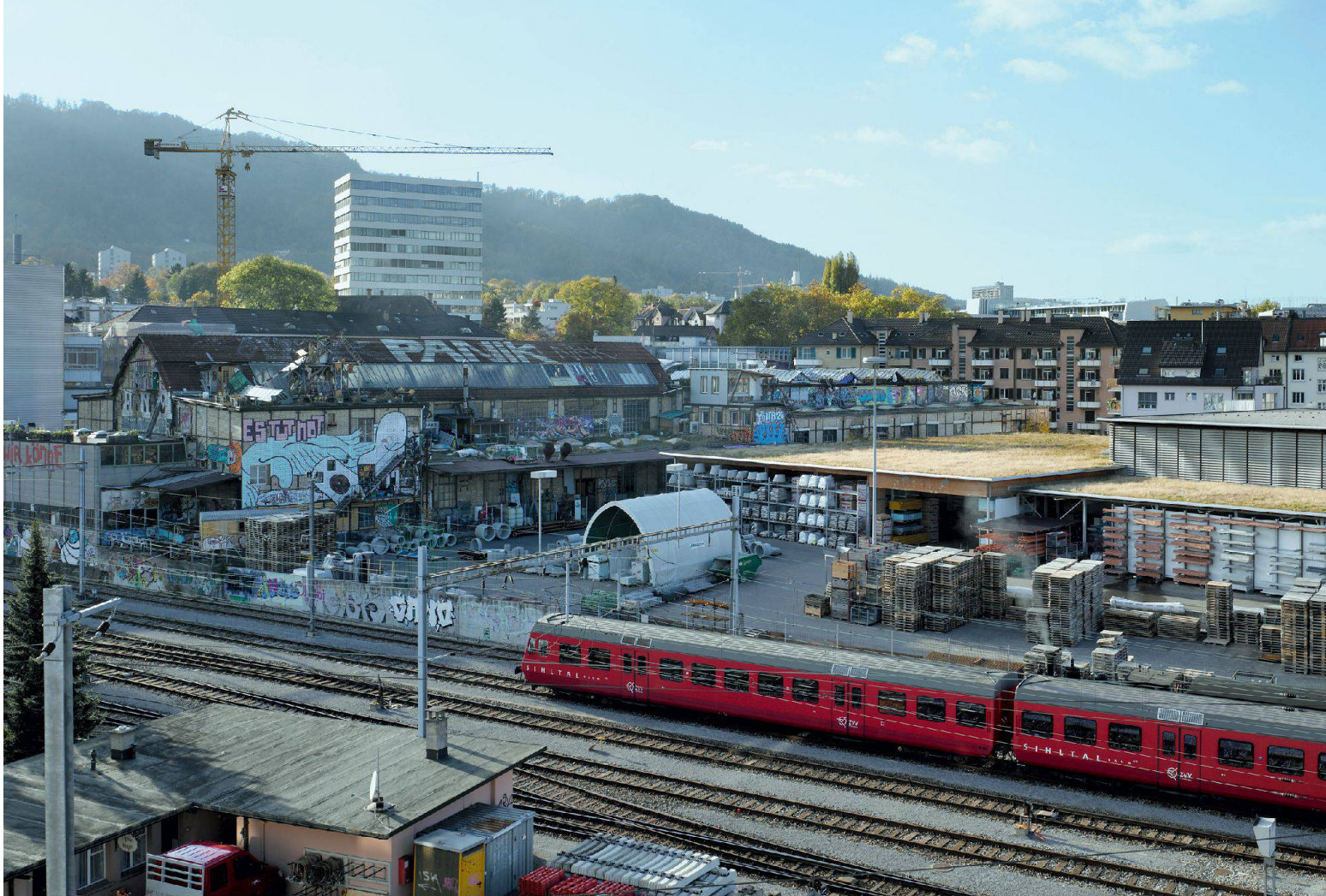
04 Nutzungsvielfalt, Raum- und Zeitschichten beim Zürcher Bahnhof Giesshübel
