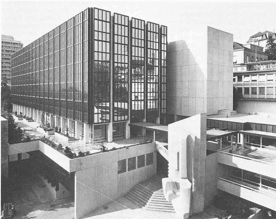
Das neue Zentralgebäude für Elektrotechnik an der Gloriosastrasse 25
