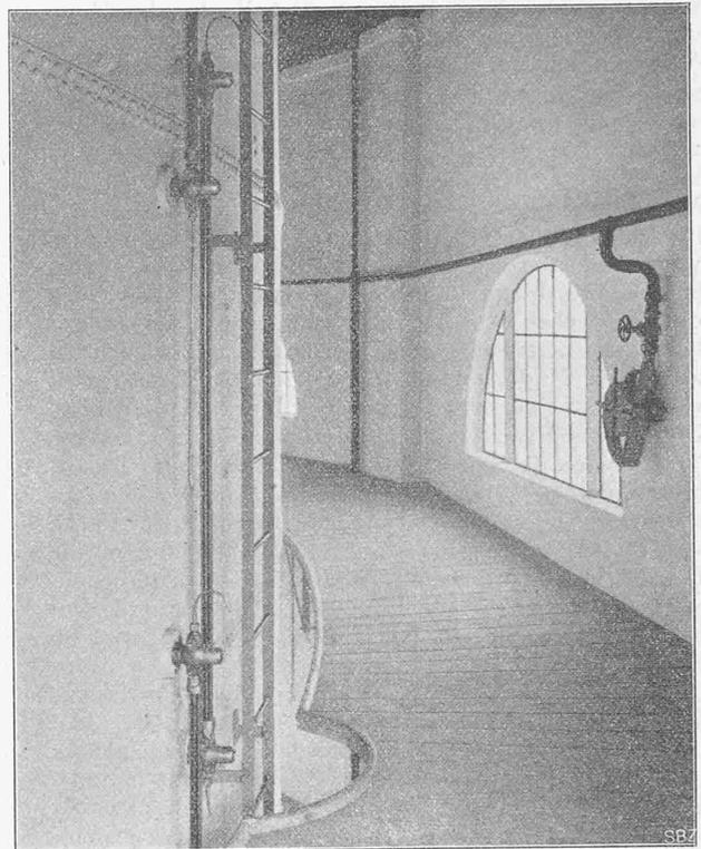
Abb. 11. Obere Revisionsgalerie und Standröhren am Behälter.
