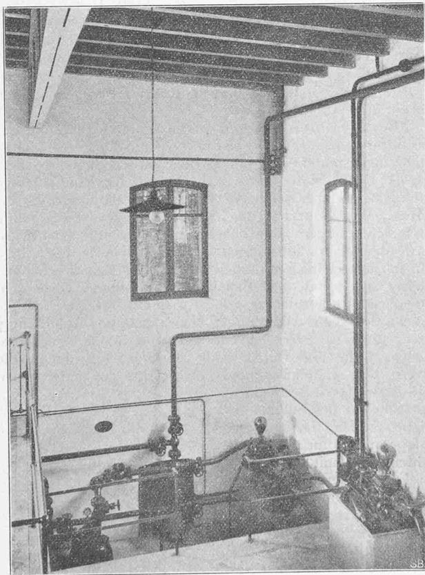
Abb. 13. Füllpumpen und Mündung des Verbindungskanals im Abfüllraum.
