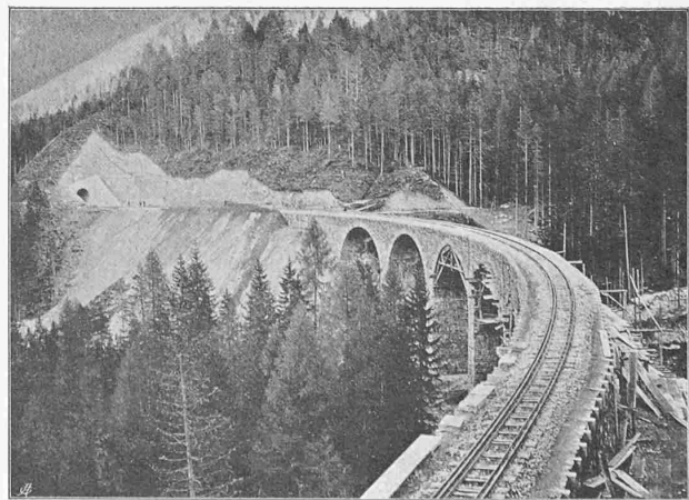
Abb. 15. Cavia-Viadukt, taleinwärts gesehen. Steilgeböschter Tunnel-Voreinschnitt in der Rauhacke.
