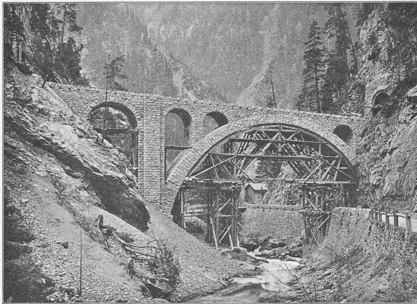
Abb. 11. Landwasserviadukt in den «Zügen», zwischen den Brombenz-Tunnels I und II.
