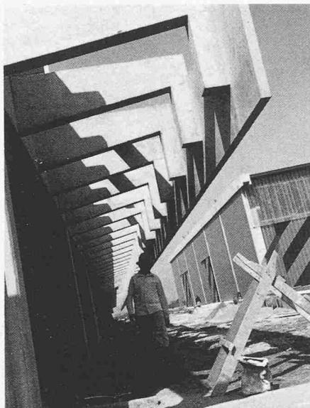
Perforiertes Vordach – Pergola – erzeugt einen natürlichen Luftdurchzug und dämmt die starke Lichtintensität. Die 2. Haut verhindert den direkten Sonnenstrahleneinfall
