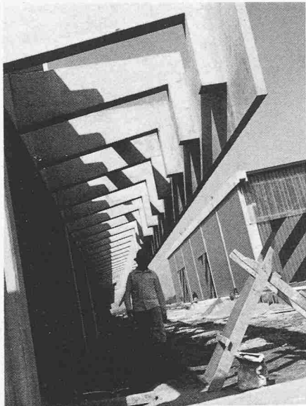
Perforiertes Vordach – Pergola – erzeugt einen natürlichen Luftdurchzug und dämmt die starke Lichtintensität. Die 2. Haut verhindert den direkten Sonnenstrahleneinfall
