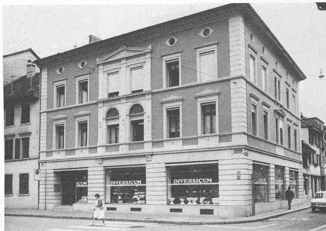
Geschäftshaus am «Graben», um 1850, renoviert 1978
