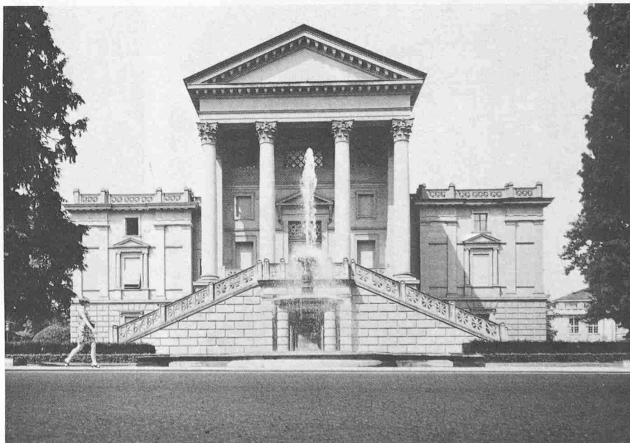
Stadthaus, erbaut 1865–1870 von G. Semper
