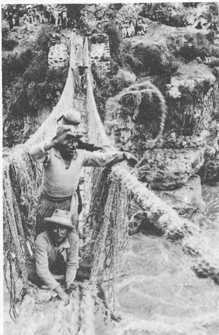
Fertigstellung von Geländer und Boden
