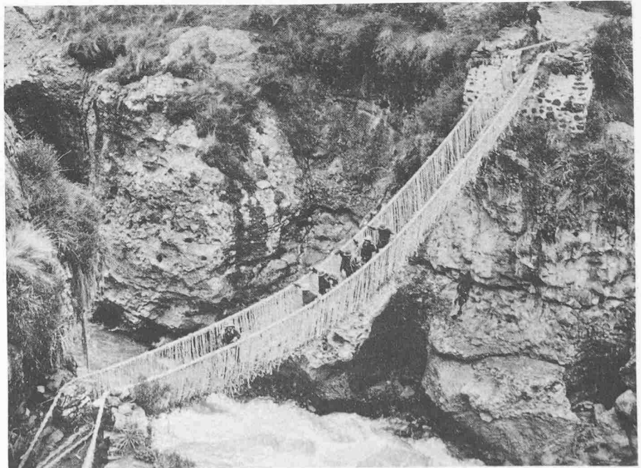
Bei stärkerem Wind schwankt die Konstruktion beträchtlich. Beim Überschreiten hat man aber ein Gefühl der Sicherheit, und die Tragfähigkeit ist erheblich
