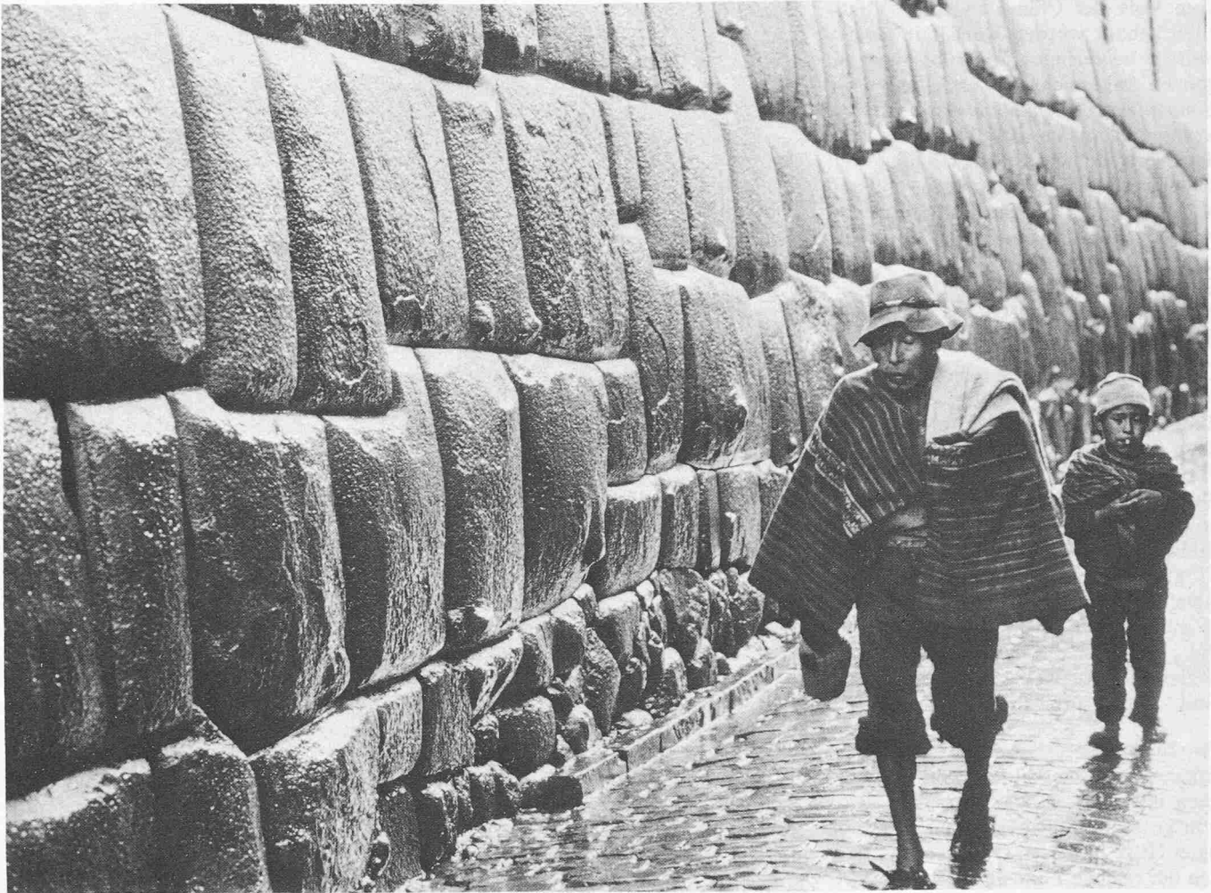
Im Herzen von Cuzco stehen die aus grünem Andesit errichteten Wände des «Palastes des Inka Roca». Dank einem Koffer aus Sand und Kies und dem fast fugenlosen Ineinandergreifen der Blöcke hat das Werk die Stabilität einer Betonmauer und hat mehrere schwere Erdbeben offensichtlich unbeschadet überlebt
