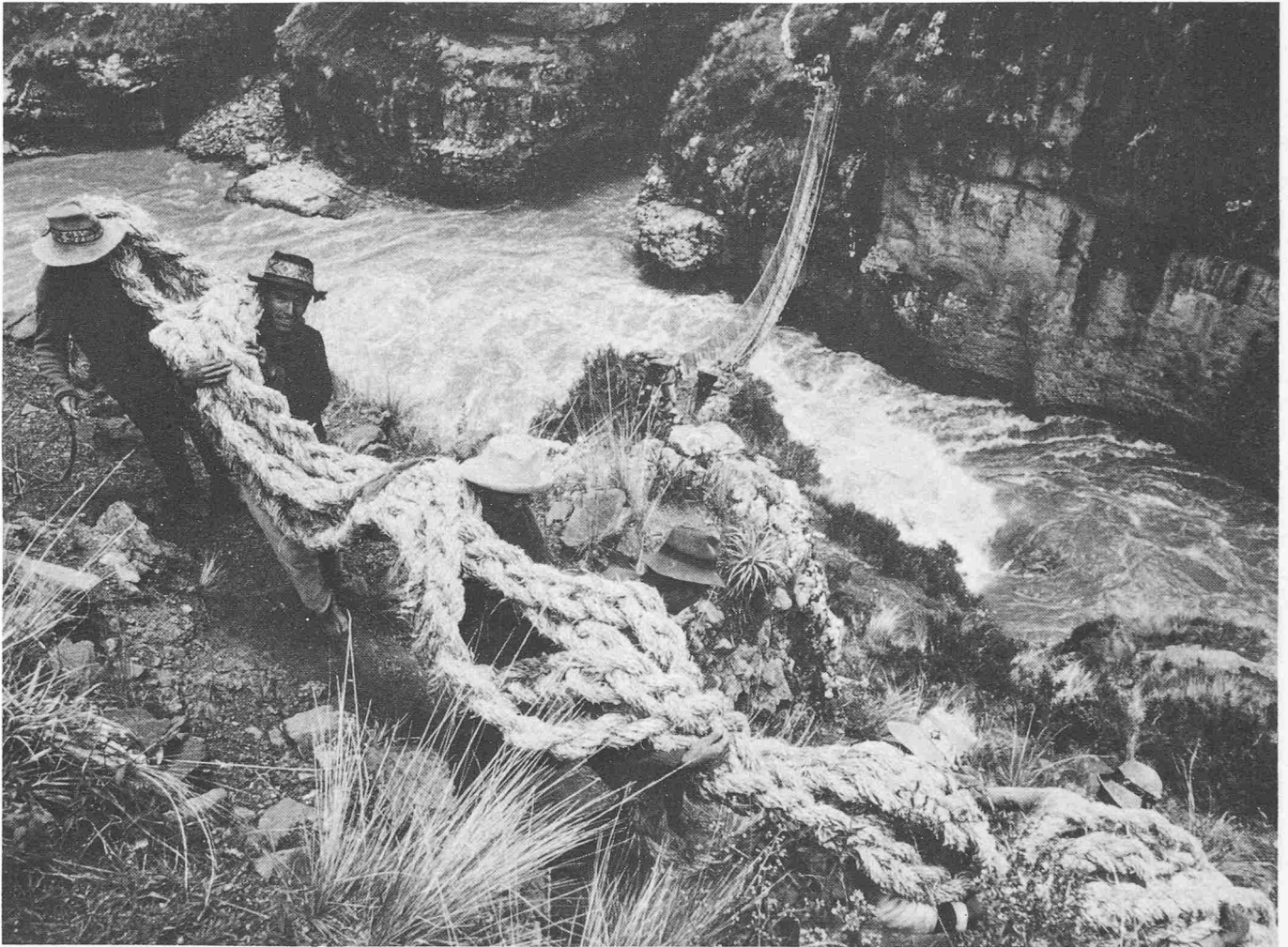
Transport des Kabels zum Bauplatz
