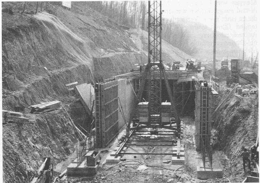
Bild 11. Bau des Tunnels in der Hangstrecke, links oben die z.T. im Kriechen befindlichen Zonen des Überdeckungsmaterialies
