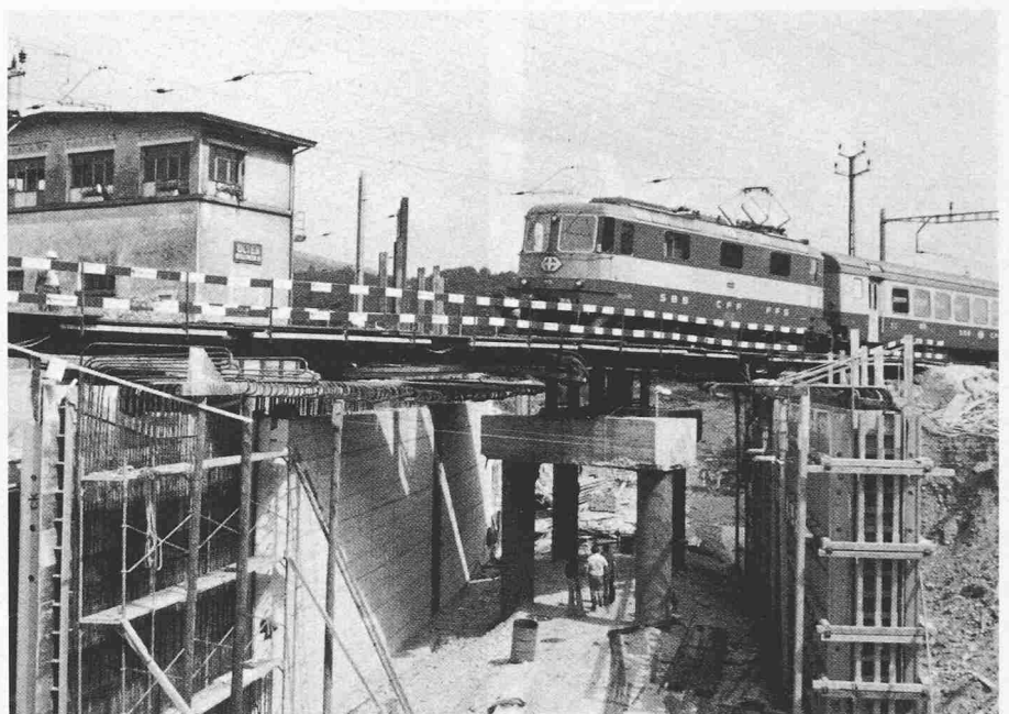
Bild 9. Bau Überwerfungsbauwerk mit den Mitteljochen zur Abstützung der Hilfsbrücken
