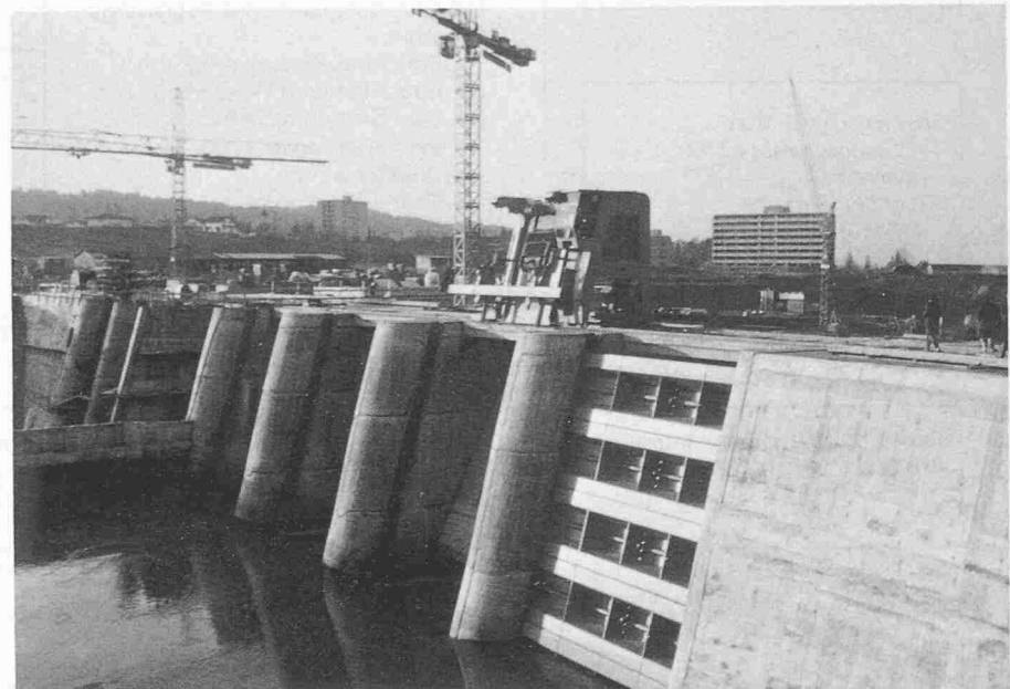
Bild 6. Kraftwerk Bremgarten-Zufikon während des Baus (Bild: R. Maurer)
