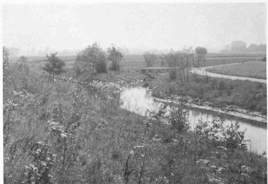
Bild 13. Hauptentwässerungskanäle in Aristau/Merenschwand (Bild: R. Maurer)
