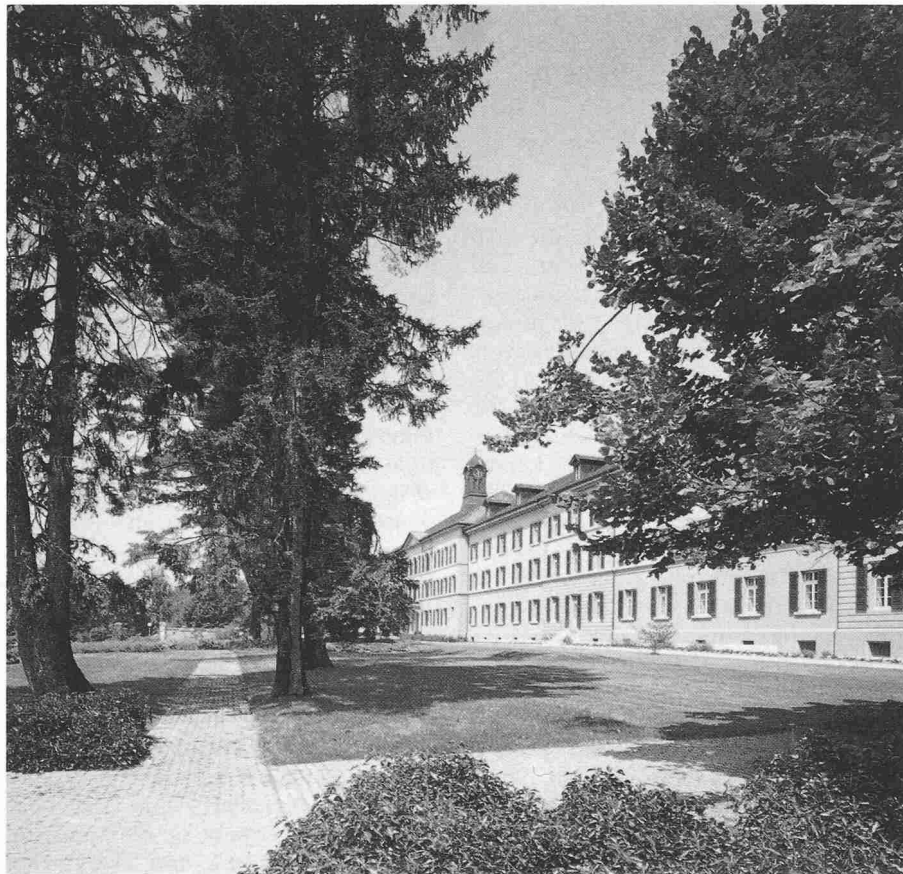
Ausschnitt Südfassade Ostteil
