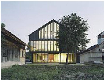
BDE Architekten, Kirchgemeindehaus Wiesendangen
