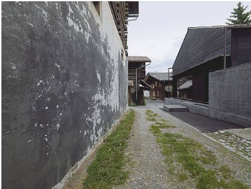
Blick von der Hauptstrasse (oben) und der hangseitige Zugang zum Atelier.
