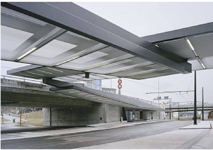
Zur Mitte hin tragen die beiden Träger der Perrondächer den dritten, quer verlaufenden Träger.
