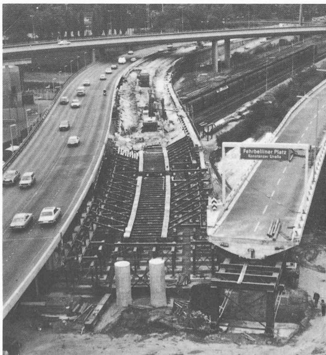
Bild 2. Übersicht. Der Verkehr rollt 4spurig über die mit Stahlkonstruktionen unterfangene Südbrücke
