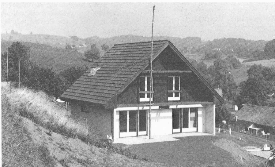
Bild 1. Messgebäude, Ansicht von Westen
