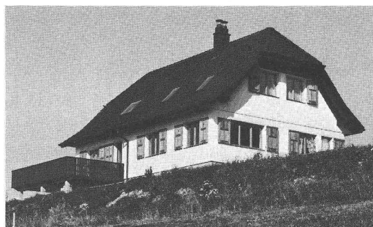
Pavillon construit en éléments de bois à Sainte-Croix
